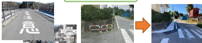
通学路の側溝に蓋をし、歩行空間を確保
